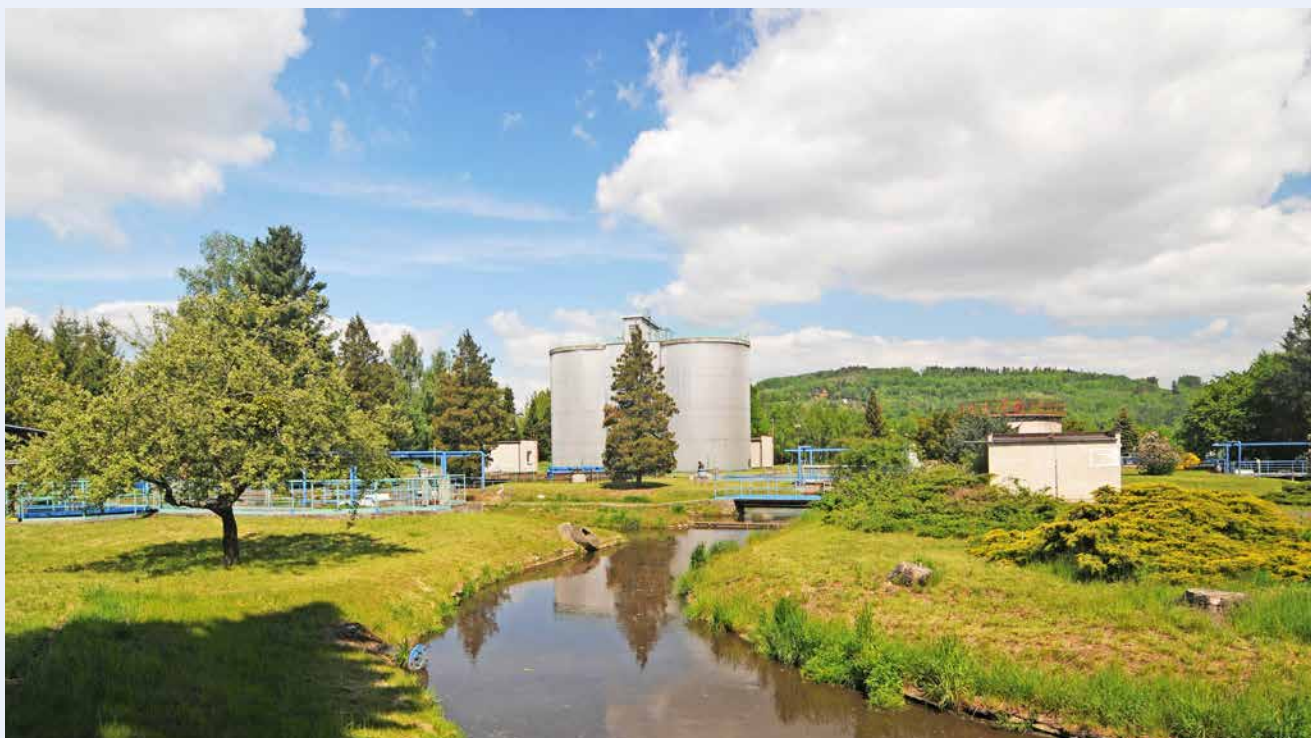
Čistírna odpadních vod Frýdlant nad Ostravicí - Byla vybudována v roce 1968, významnou rekonstrukcí prošla v roce 2005. Je projektována pro vyčištění odpadní vody pro 15 000 ekvivalentních obyvatel. Ročně dokáže vyčistit až 1,45 milionu metrů krychlových odpadní vody.
