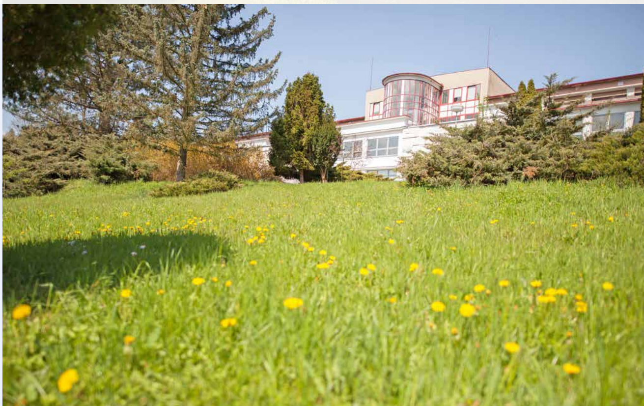
Úprava vody Podhradí - Největší úprava vody společnosti SmVaK Ostrava s kapacitou 2 700 litrů za sekundu zásobující Kružberský skupinový vodovod, tedy západní a severní část Ostravského oblastního vodovodu. Byla uvedena do provozu v roce 1958 a zpracovává surovou vodu z kaskády údolních nádrží Slezská Harta a Kružberk.
